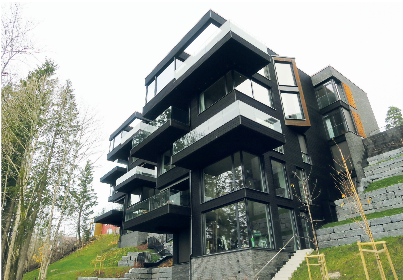
Store vinduer gir ikke bare panoramautsikt mot sør og vest, men er også en vesentlig del av fasadeuttrykket.
